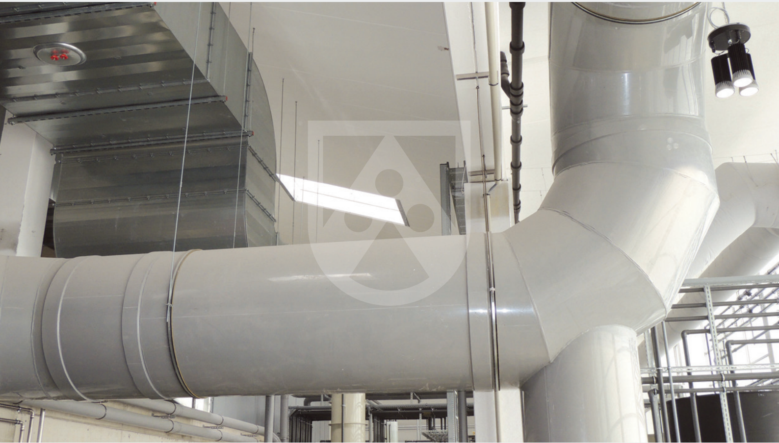
Ventilation ducts made from flame-retardant Polystone® PPs grey Lüftungsleitungen aus dem schwerentflammaren Polystone® PPs grau
